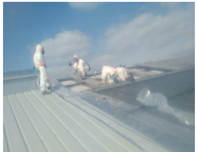
© Isotop Etancheité Opérateurs en équipement de désamiantage – nettoyage de la charpente
